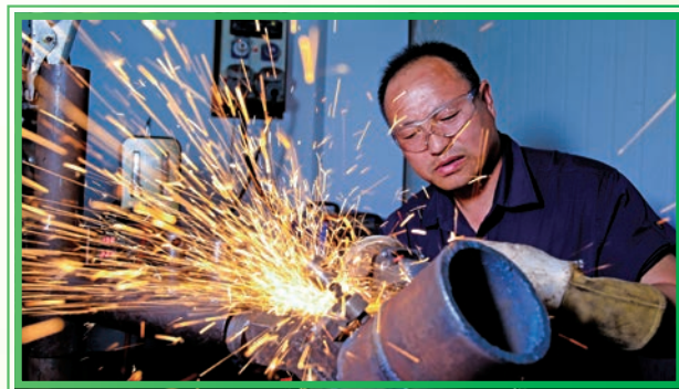
焊工技能大師演示組對管道環縫焊接
