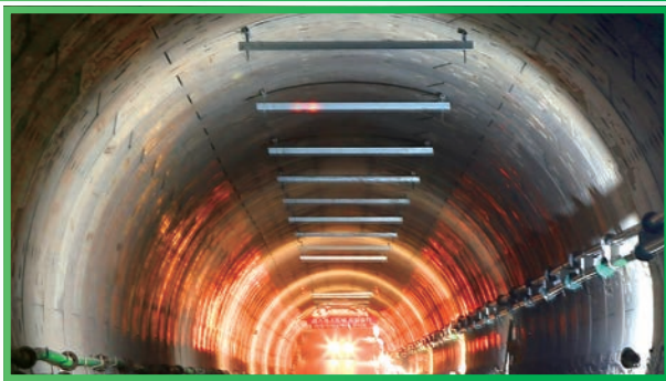
國內首座TBM長距離大坡度煤礦斜井施工
