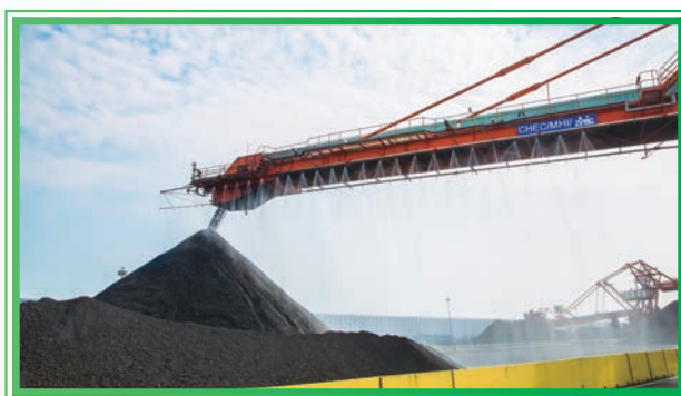
黃驊港粉塵治理—堆料機大臂灑水
