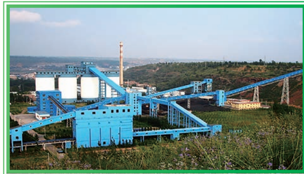
神東煤炭集團煤礦廠區
